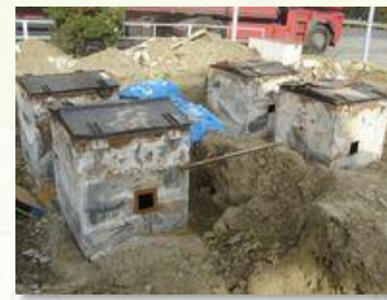
Prebiehajúca rekonštrukcia čerpacej stanice PHM.
