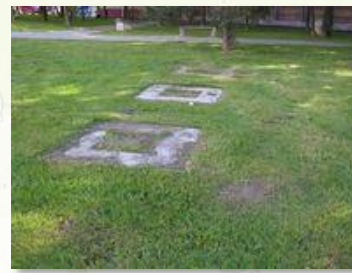
Miesto po bývalej čerpacej stanici PHM so zvyškami zariadení.
